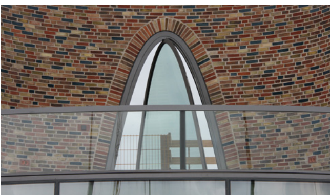
PROJEKT „Kirk-Lego Dänemark“ Entwicklung, Prototypenbau und Montage von Türen aus 3D-gebogenen Stahlprofilen.
