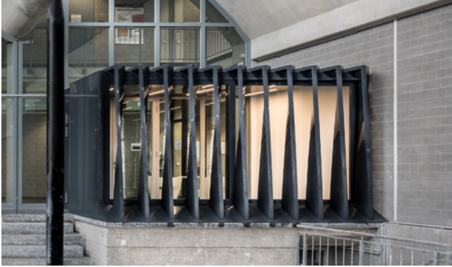
PROJEKT „Lehrbauhof Salzburg“ Längsseitige Verdrillung von Lamellen.
