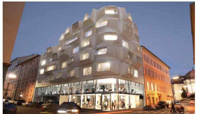
PROJEKT „Argos“ Komplettfertigung von „schwimmenden“ Klappfenstern aus Stahlprofilen mit gerundeten Ecken.
